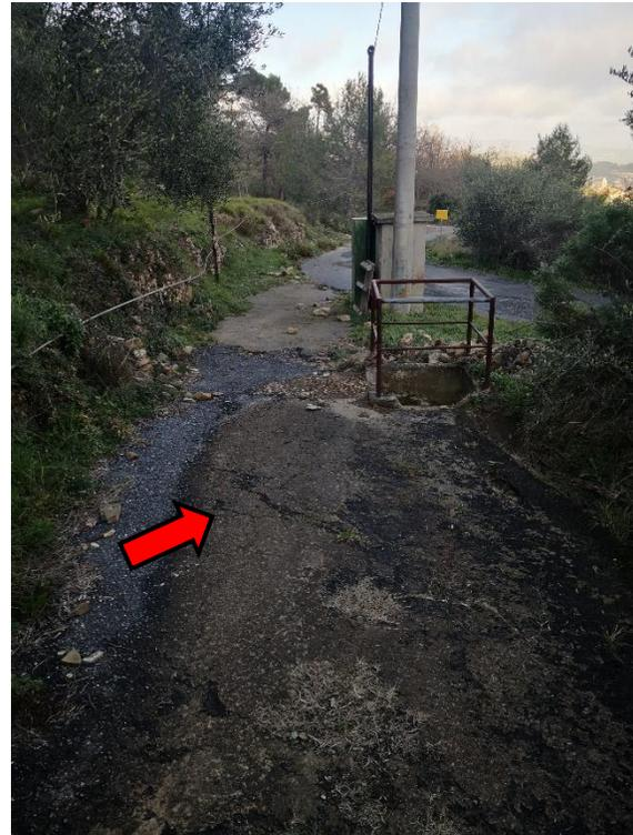
Foto dove risulta visibile il dilavamento lungo la viabilità e il pozzo intasato dal materiale detritico
