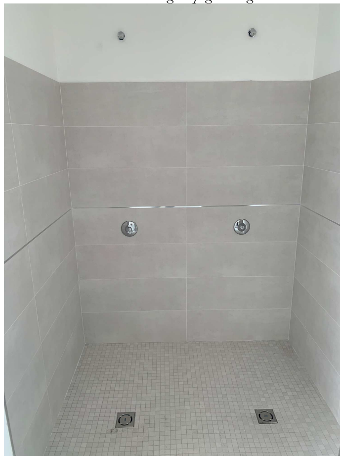
Foto F - Vista dettaglio spogliatoio giocatori - docce
