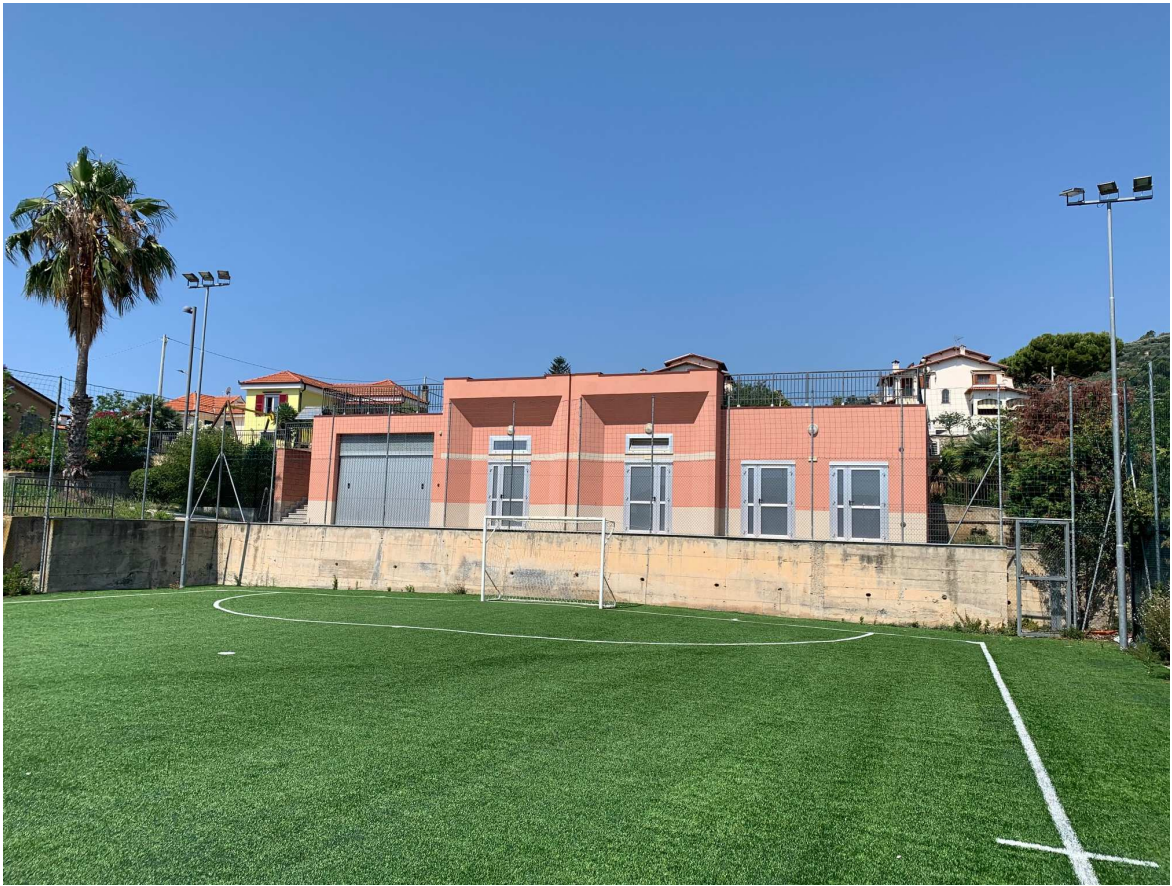
Foto C - Vista generale campo e fabbricato
