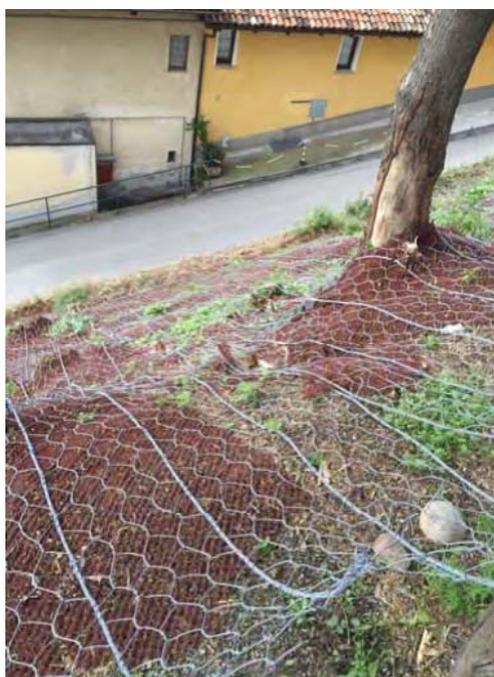
**Sistemazione frana in via Gaidano e particolare rete di protezione per consolidamento del versante**
