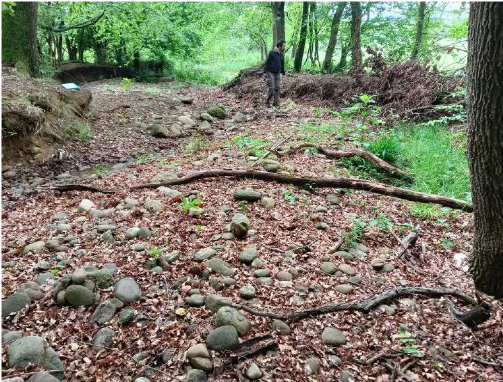
Figura 8-2 – Stato dell'alveo del rio laterale che attraversa strada dei Galliassi: si osservano le erosioni sia in sponda destra e successivamente in sinistra, causate dall'azione dell'acqua durante le ondate di piena. (foto: 3650-IMG20230510121736)
