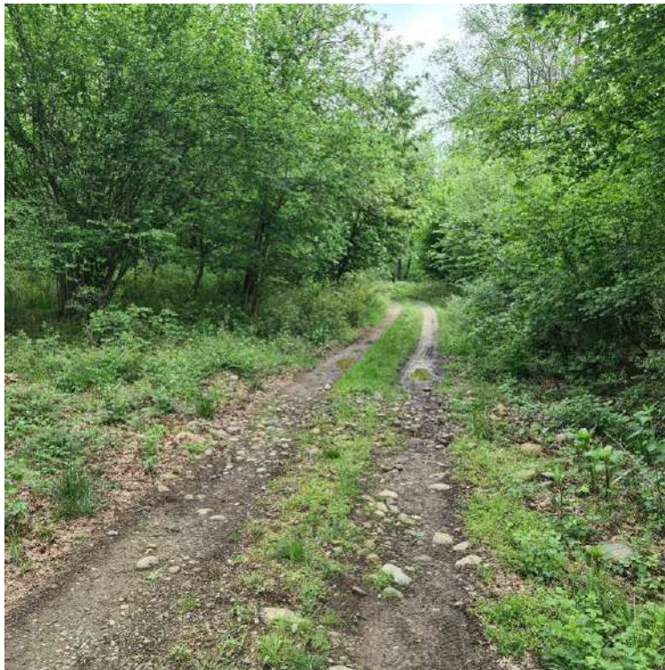
Figura 9-3 – Punto di strada dei Galliassi in cui l'acqua non più trattenuta dall'alveo attraversa la carreggiata stradale guadandola. (foto: 3650-20230510_134437)
