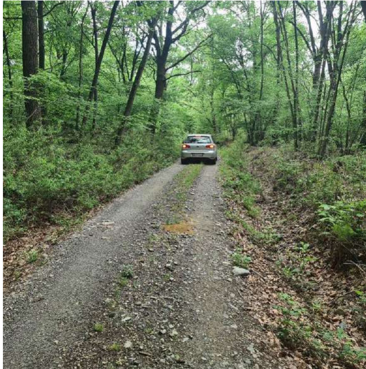
Figura 10-2 – Uno dei punti in cui si rileva l'attraversamento della carreggiata da parte delle acque meteoriche. Si provvederà alla realizzazione di tagliacqua in terra per regolarne il deflusso. (foto: 3650-20230510_144606)
