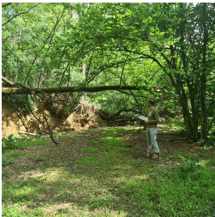
Figura 6-3 – Erosione di sponda sinistra del Rivo Bossa presso il parco giochi. (foto: 3650-20230510_161902)
