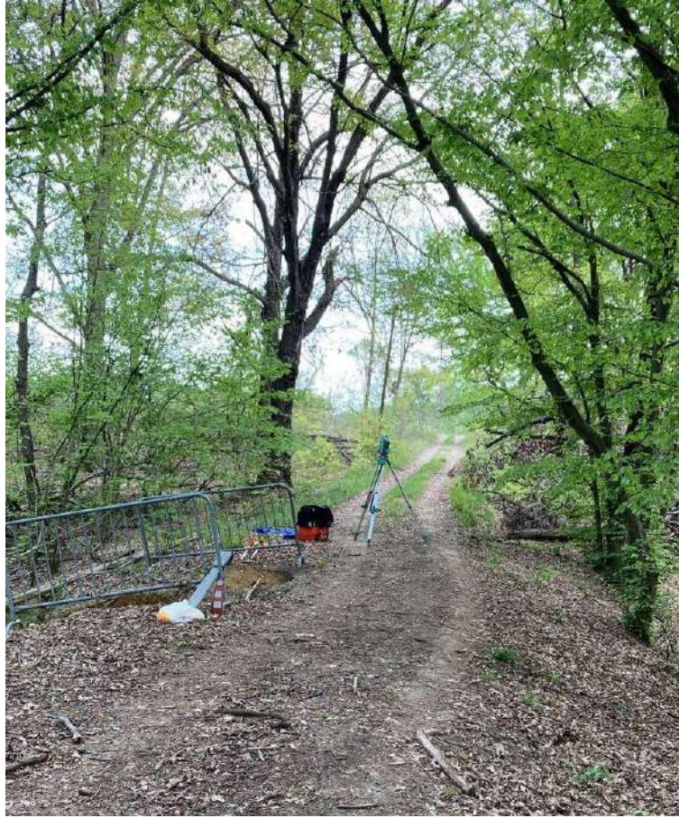
Figura 2-17 – Strada Cuminetti dissestata presso l'attraversamento. (foto: 3636-JQST4630)
