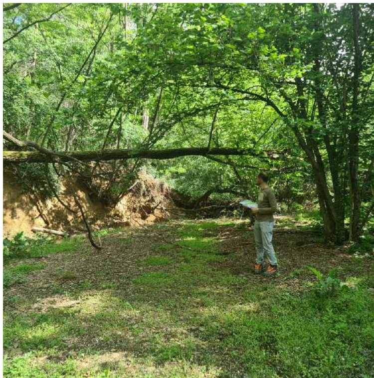
Figura 2-23 – Erosione di sponda sinistra del Rivo Bossa presso il parco giochi. (foto: 3650-20230510_161902)
