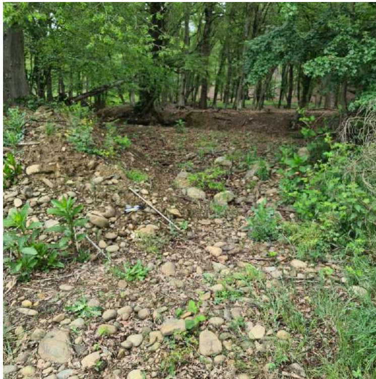
Figura 2-33 – Punto in cui il rio esce dal bosco e guada la strada in maniera incontrollata. In questo punto si realizza una briglia in legname e pietrame per convogliare correttamente le acque nel successivo guado in massi in progetto. (foto: 3650-20230510_114527)
