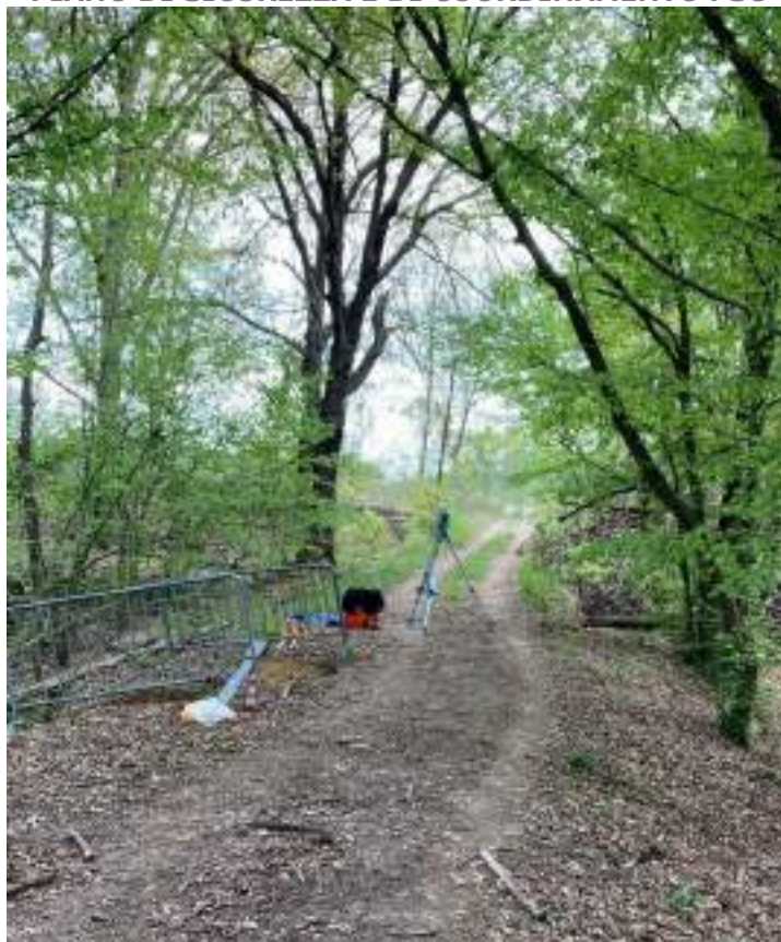
Figura 13 – Strada Cuminetti dissestata presso l'attraversamento. (foto: 3636-JQST4630)
