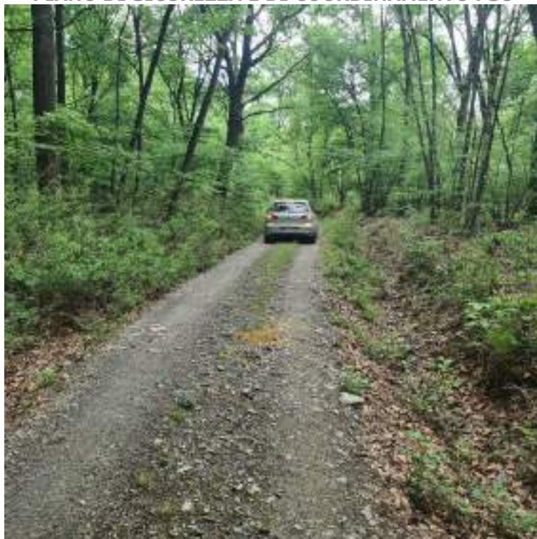
Figura 40 – Uno dei punti in cui si rileva l'attraversamento della carreggiata da parte delle acque meteoriche. Si provvederà alla realizzazione di tagliacqua in terra per regolarne il deflusso. (foto: 3650-20230510_144606)
