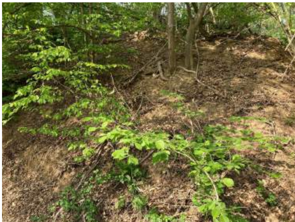
Figura 24 – Dissesto diffuso del versante prospiciente Viale dei Roveri. (foto: 3639-IMG_8469)
