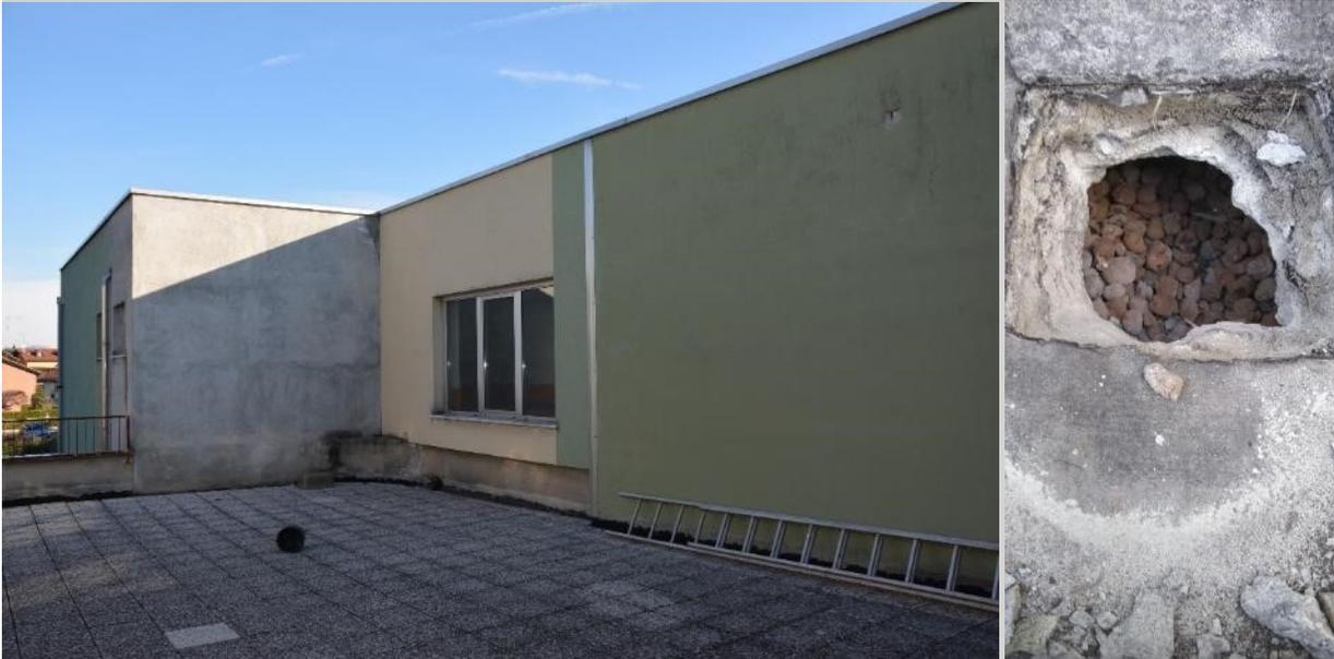
Figura 20 – Solaio zona di intervento 2 e saggio eseguito sullo stesso
