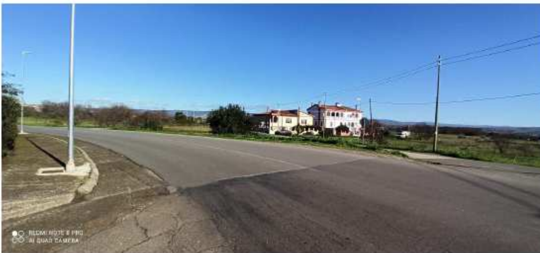
Vista dell'andamento in curva in prossimità dell'intersezione (Fig. B)
