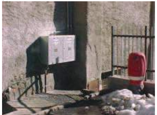
89.90. alcuni interventi invasivi su edifici
