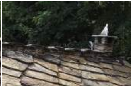
Realizzazione corretta del colmo
