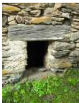
Borgata Balziglia: esempi di aperture realizzate con architrave ligneo
