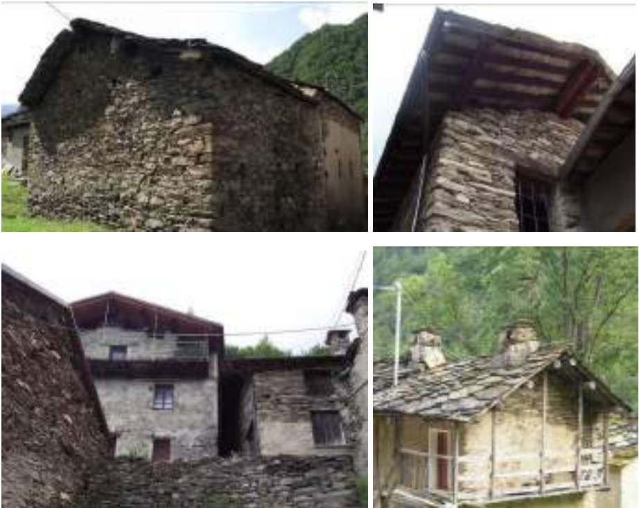
Massello: alcuni esempi di edifici realizzati in murature a vista
