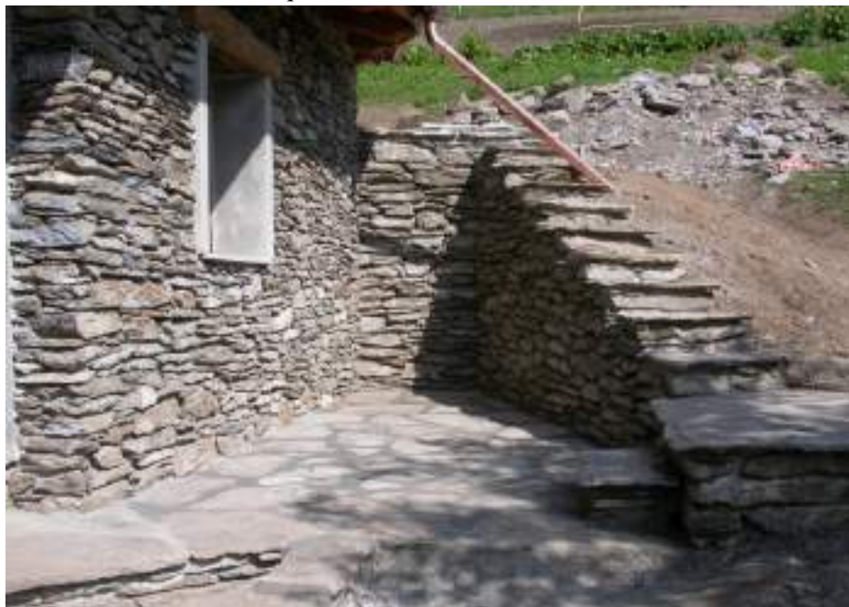
Esempio di muro di sostegno realizzato nel Comune di Massello
