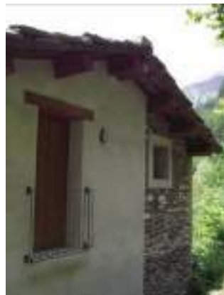
Edificio interessato da un intervento edilizio in Borgata Porence
