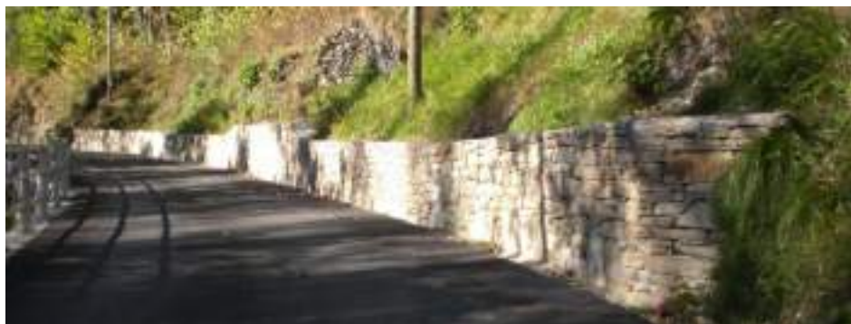
Esempi di muri di contenimento realizzati nel Comune di Massello
