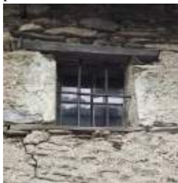
Borgata Balziglia: esempi di aperture realizzate con architrave ligneo
