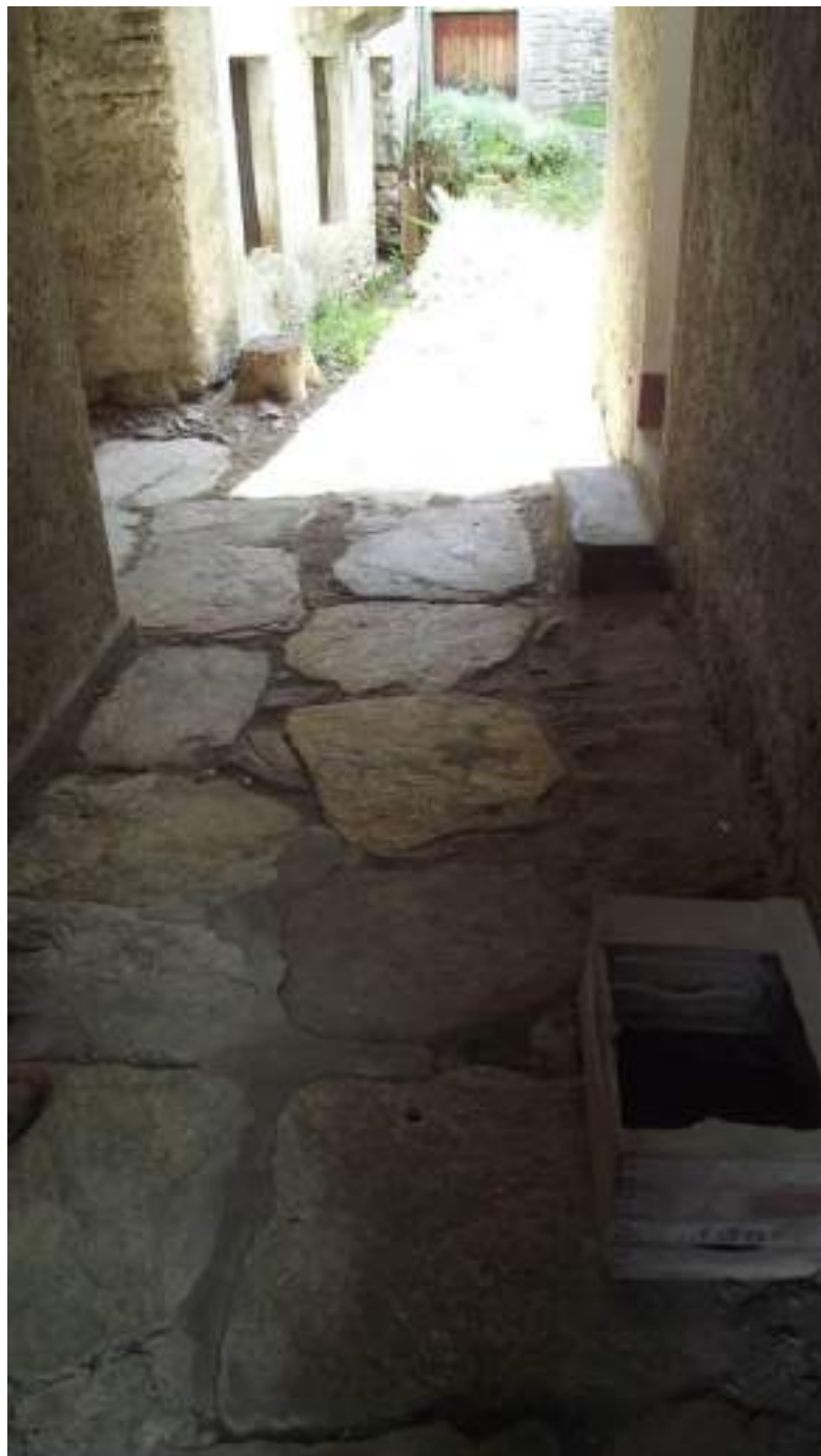
Lastricato realizzato con lose vecchie e di scarto in Borgata Roberso
