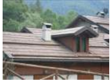
Esempio di tetto in lose e in scandole di legno
