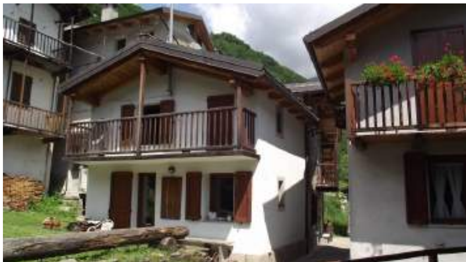
Serramenti: esempi in Borgata Campo la Salza
