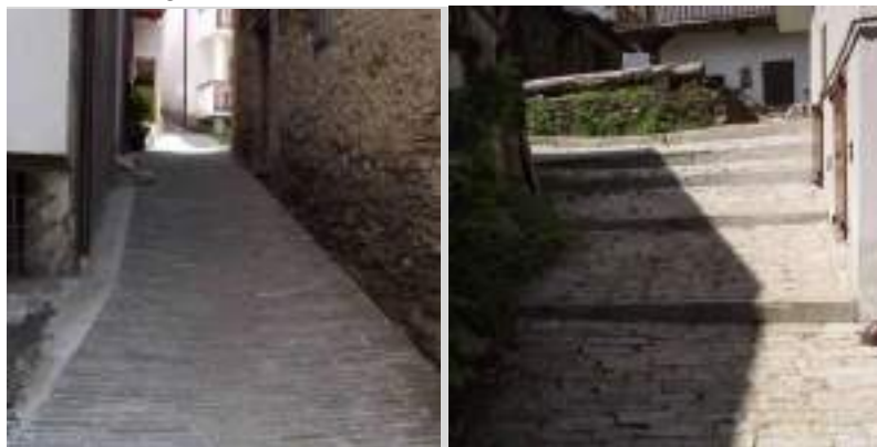
Pavimentazione lineare con scampoli di pietra posate ortogonalmente al piano stradale, ammessa se posata linearmente (Borgata Roberso), sconsigliata se posata con gradoni (Borgata Campo la Salza)
