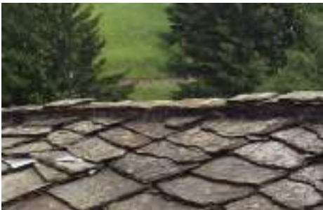
Realizzazione corretta del colmo
