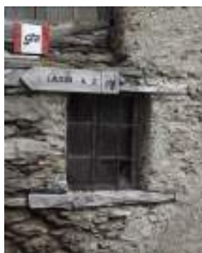
Borgata Balziglia: esempi di aperture realizzate con architrave ligneo
