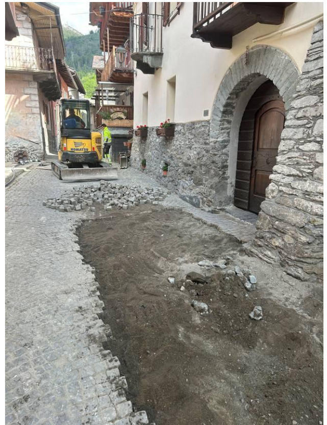
La fase di ripavimentazione
