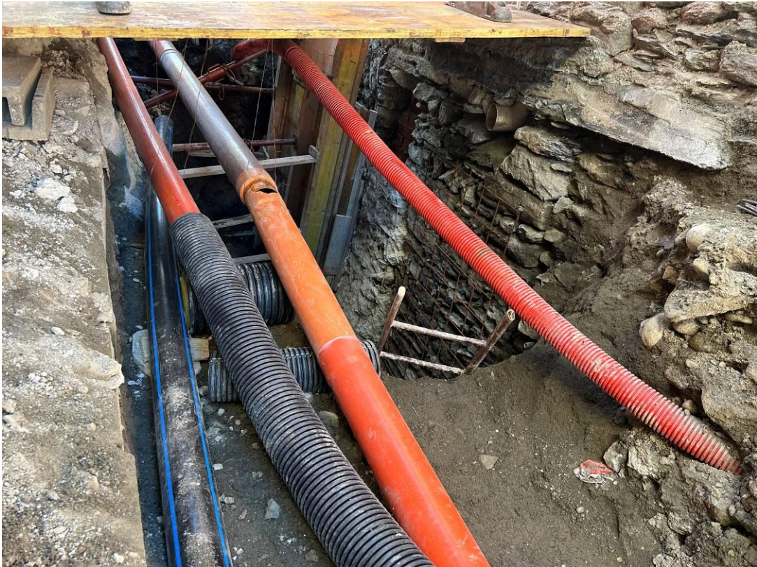
Un tratto dello scavo su via Albert Deffeyes.
