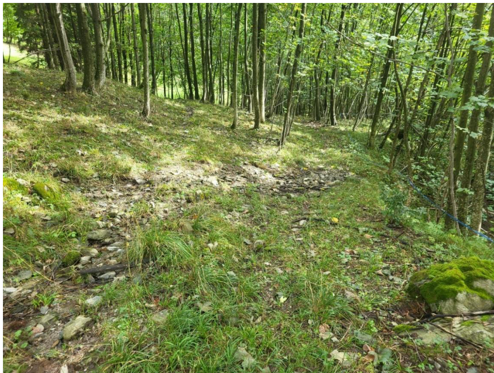
Foto 1 – Vista del sentiero comunale in dissesto per erosione a causa del ruscellamento incontrollato
