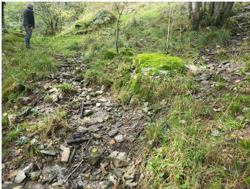
Foto 2 – Sentiero completamente in erosione a causa del ruscellamento incontrollato delle acque di versante
