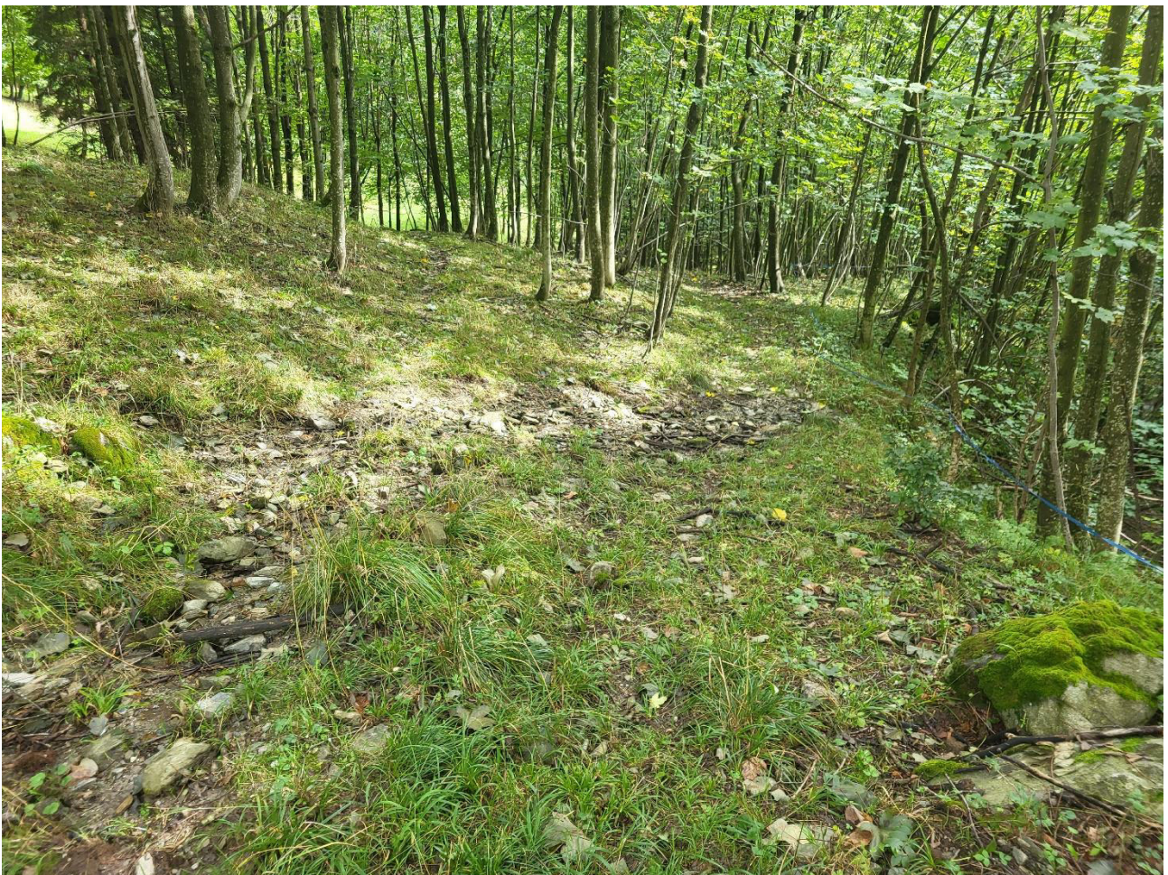
Figura 3 – Vista del sentiero comunale in dissesto per erosione a causa del ruscellamento incontrollato
