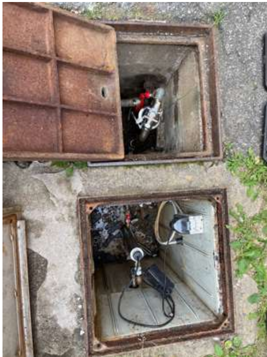
Filtro e lampada UV Fontana Burnel
