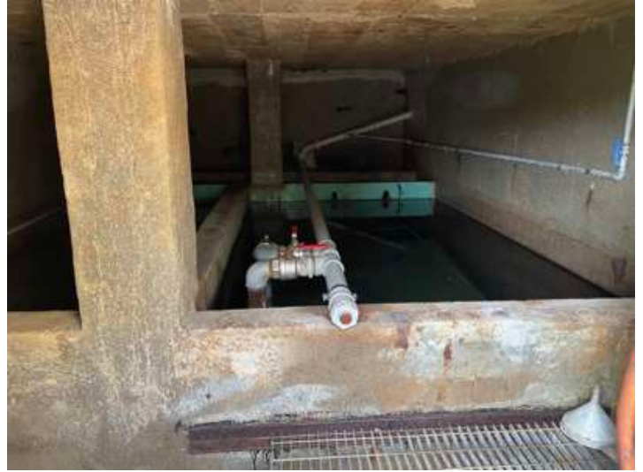
Vasca fontanelle interna capacità 10 mc
