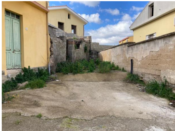
4 _ Piazza IV Novembre (area d'intervento_ stato attuale)
