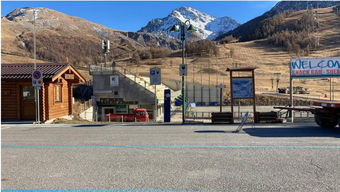
Ambito oggetto di intervento AO3, area “Corpo di fabbrica 2” vista dal piazzale Kandahar
