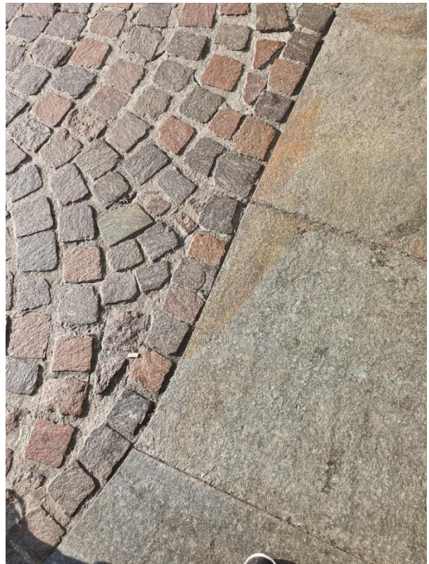
Pavimentazione in lastre di pietra e cubetti di porfido
