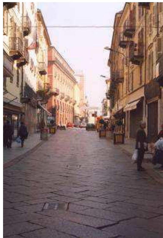
Pavimentazione in lastre di pietra posate in diagonale
