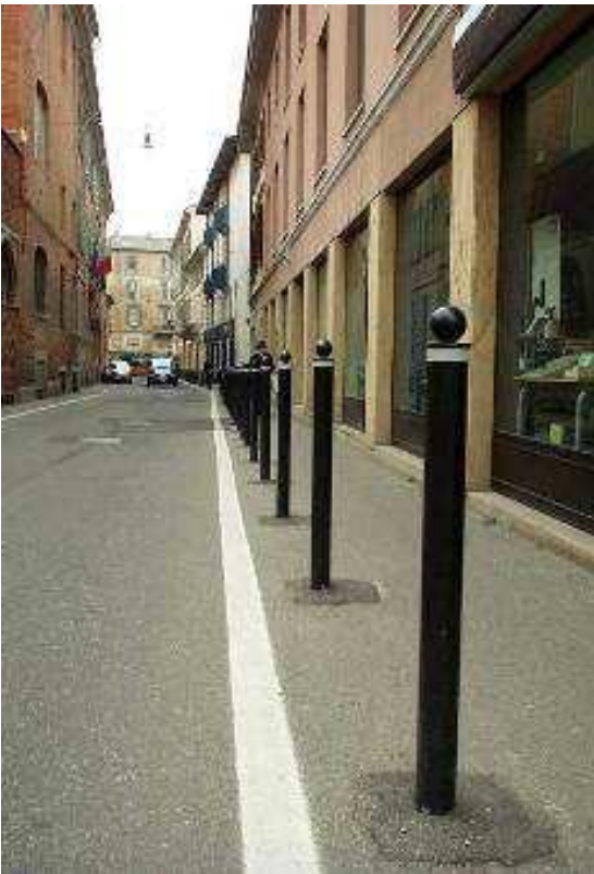
Dissuasore in metallo
