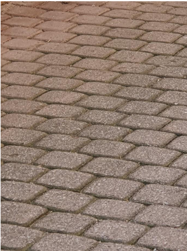
Pavimentazione esistente lungo via vittorio Emanuele
