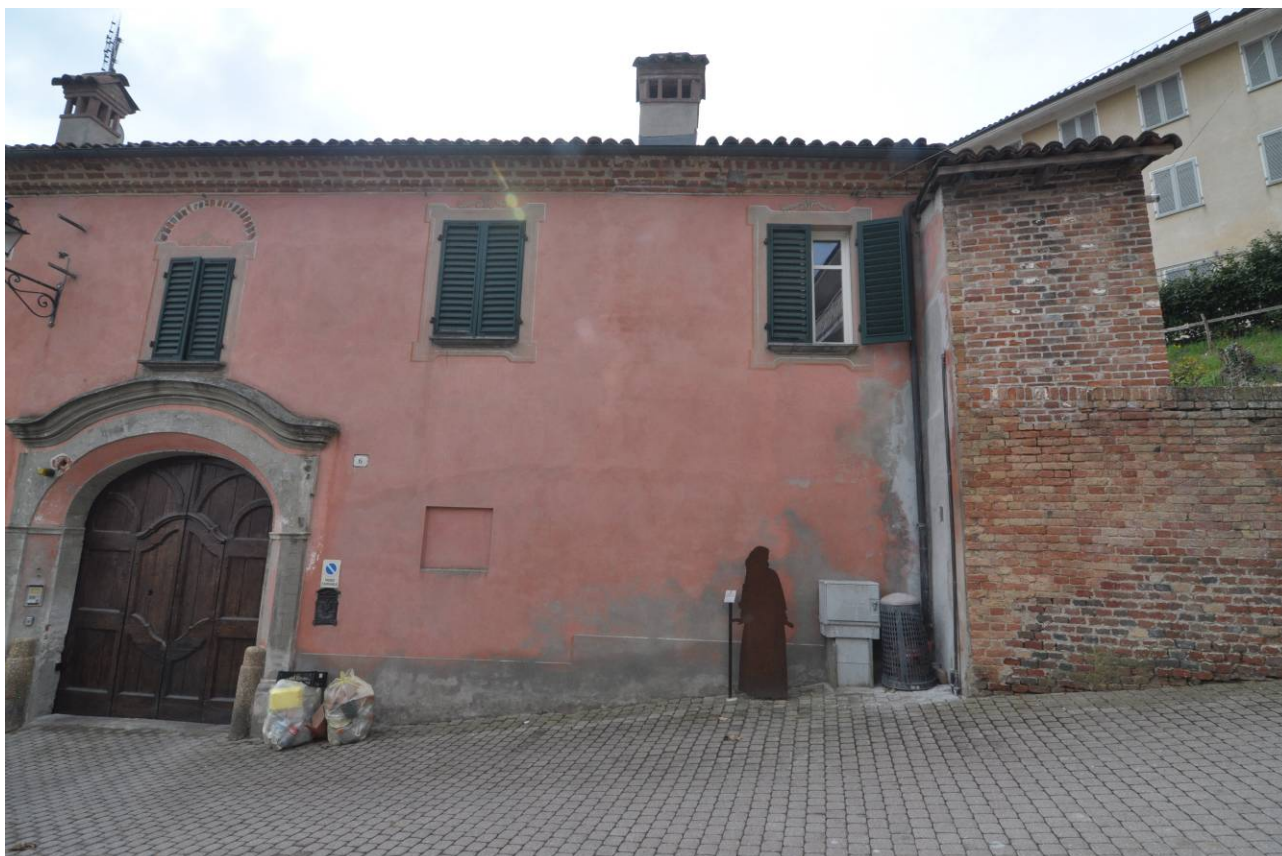
ZOCCOLO DI INTONACO IN RILIEVO
