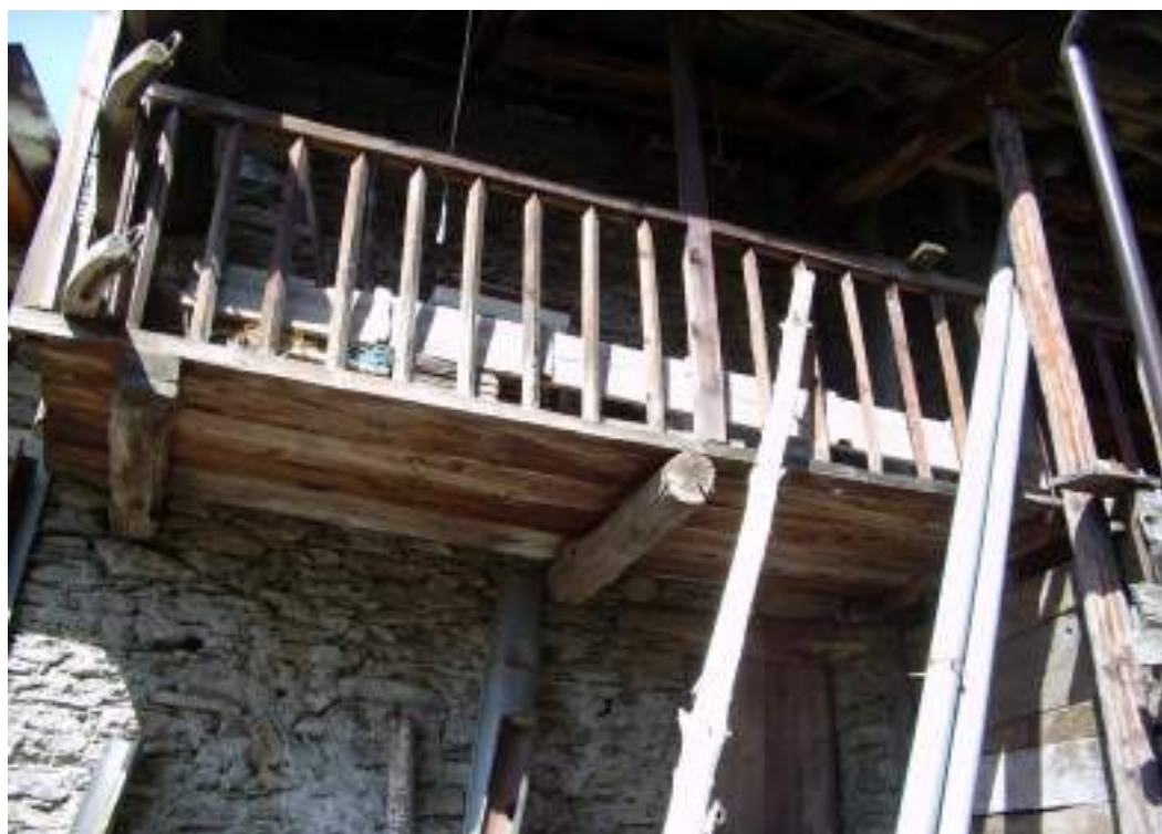
R0703306_n3 – Prospetto est – balcone in legno
