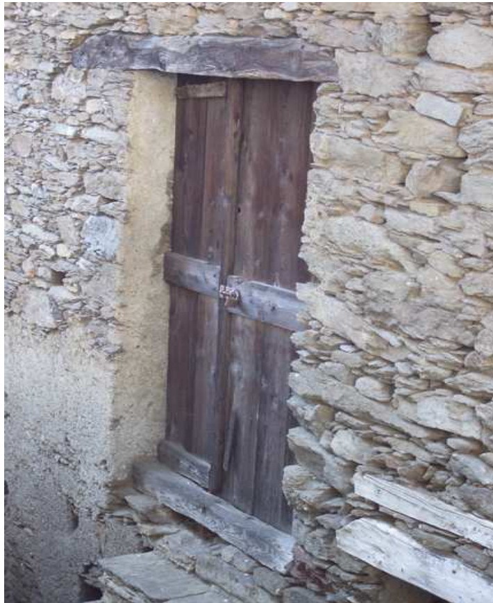
R0703305_n3 – Prospetto est – particolare ingresso
