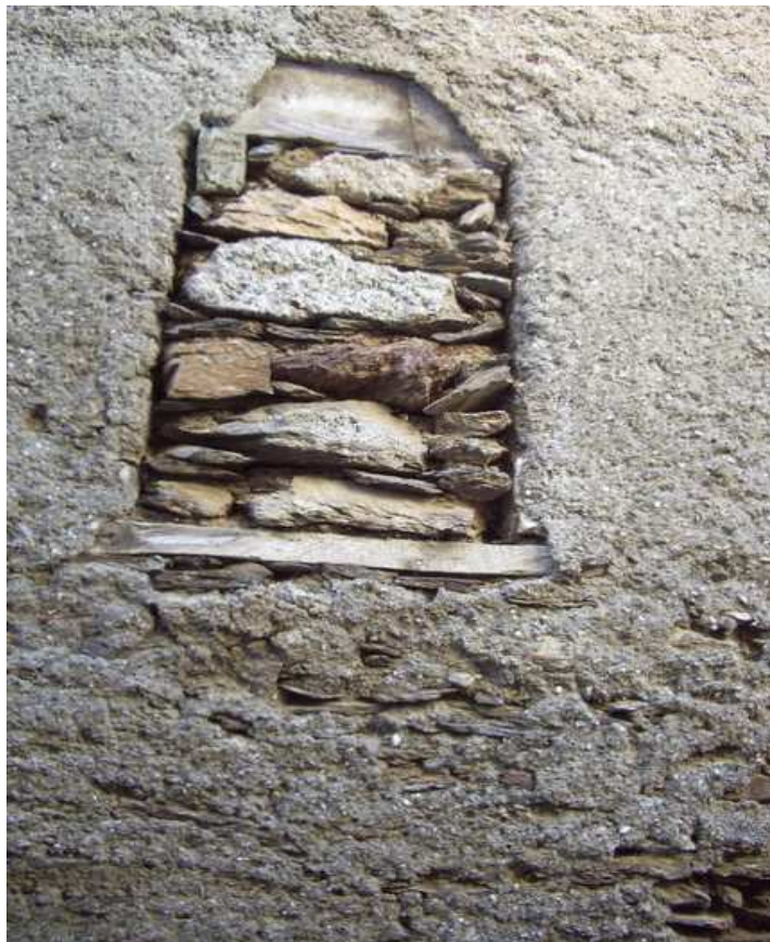
R0703305_n5 – Prospetto ovest – particolare apertura tamponata
