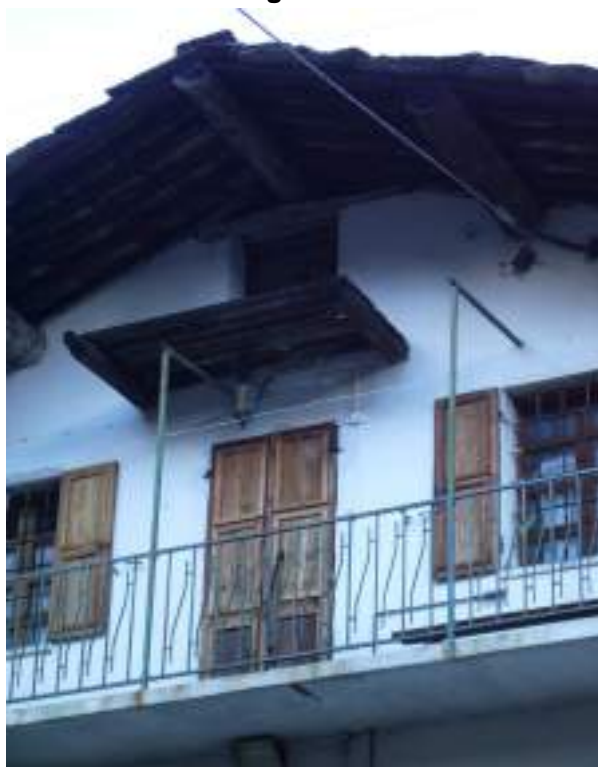
R0703304_n3 – Aperture al primo piano e accesso al sottotetto
