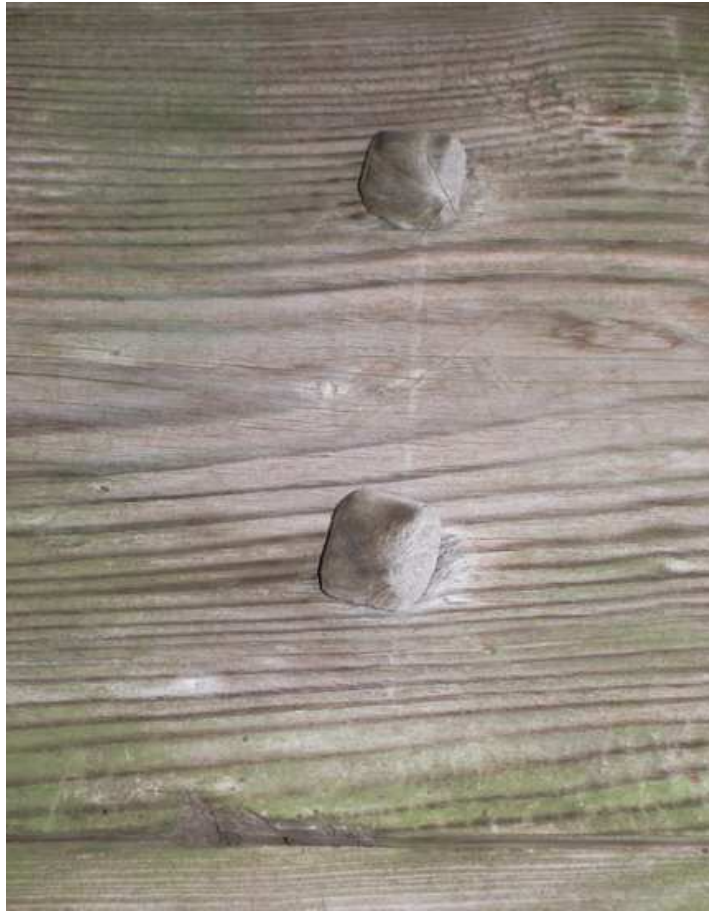
R0703310_n3 – Particolare cavicchi lignei
