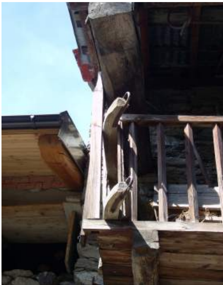
R0703306_n4 – Particolare balcone in legno
