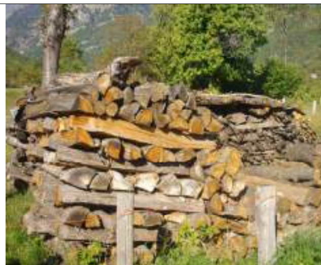
Fig.6 Legnaia coperta da ondulato, reso quasi impercettibile dalla sovrapposizione di parte del legname a Villar Pellice (netta mitigazione dell'impatto)
