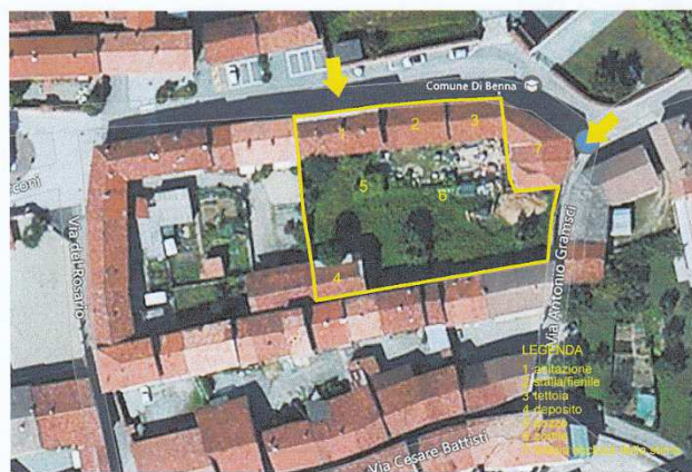
b) vista aerea di Cascina Chiesa con evidenziata la porzione oggetto di stima
