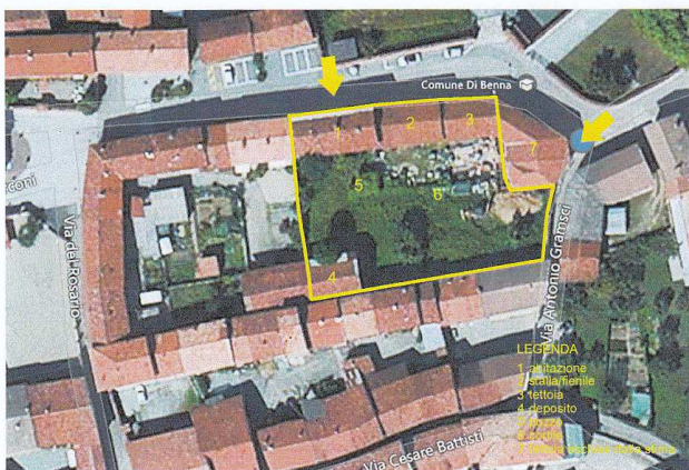
b) vista aerea di Cascina Chiesa con evidenziata la porzione oggetto di stima
