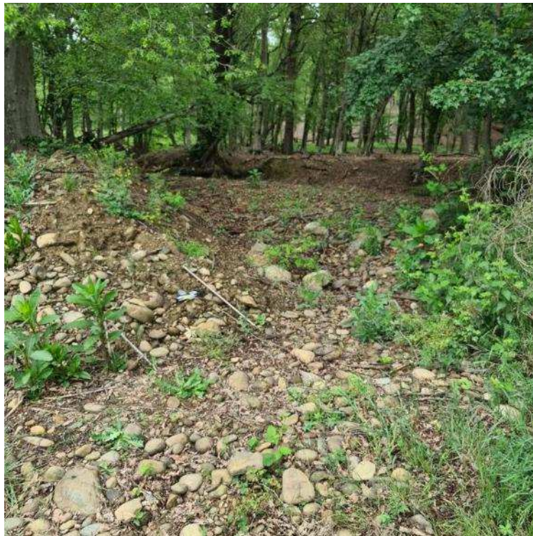
Figura 2-29 – Punto in cui il rio esce dal bosco e guada la strada in maniera incontrollata. In questo punto si realizza una briglia in legname e pietrame per convogliare correttamente le acque nel successivo guado in massi in progetto. (foto: 3650-20230510_114527)
