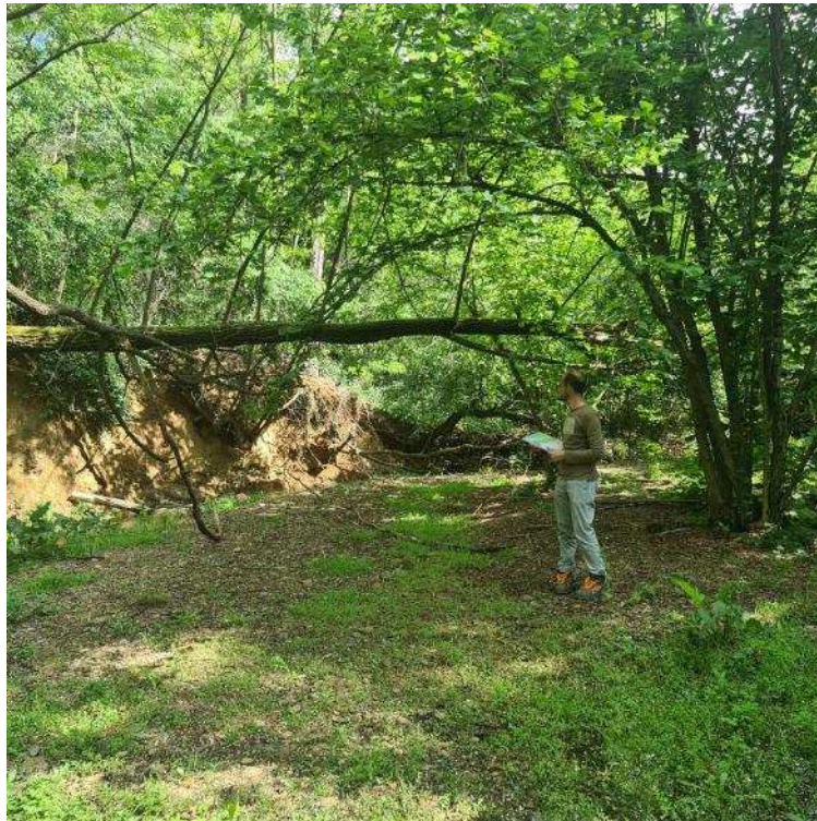
Figura 2-19 – Erosione di sponda sinistra del Rivo Bossa presso il parco giochi. (foto: 3650-20230510_161902)
